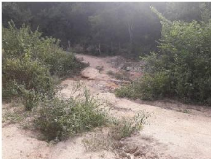
Figura 4 - Estrada de Jenipapo em condições inadequadas para acesso
