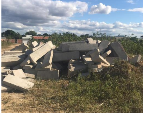
Figura 8 - RCC descartado em via pública do distrito de Taquaral de Minas
